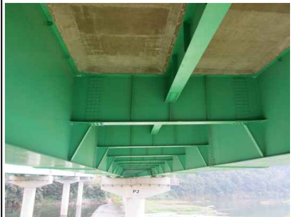
주형외부 및 바닥판 전경
